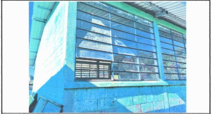
Foto 2: Se puede observar piezas de vidrios faltantes y en mal estado modulo 1 y 3
