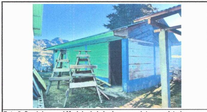
Foto 5: Se observa el Modulo de la bodega con pintura en deterioro y reposición del piso.
