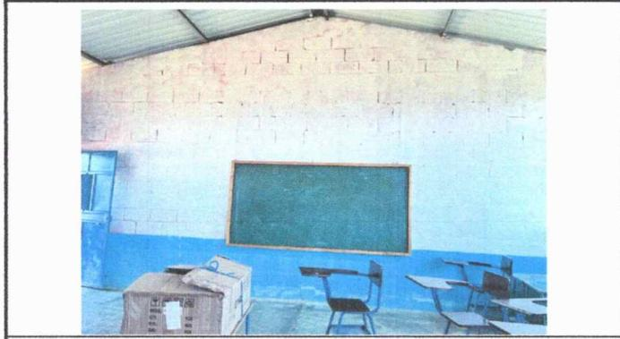
Foto1: Se observa el deterioro de pintura en la estructura de las aulas de los modulos 1,2,3.
