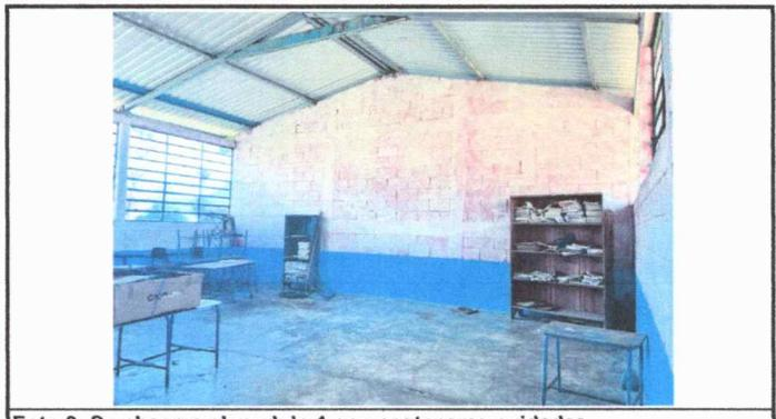
Foto 6: Se observa el modulo 1 con costaneras oxidadas
